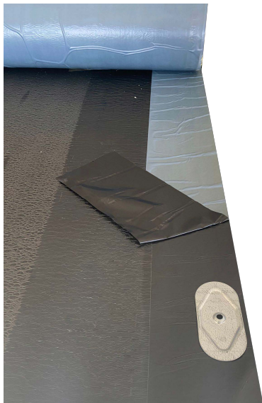
posizionare il fissaggio sotto cimosa
